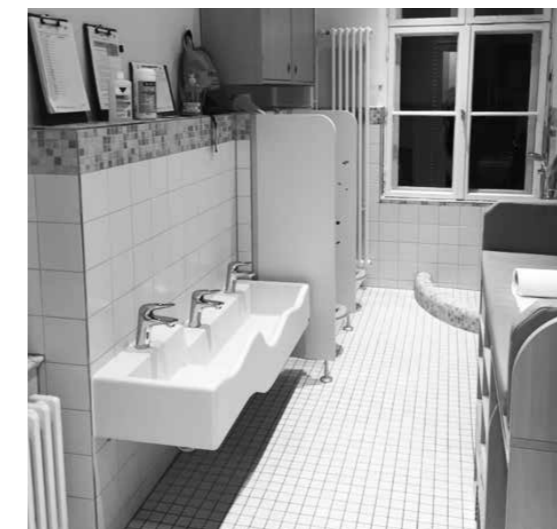
■ Bäderausbau im Rahmen der Teilsanierung in der Kita "Du & Ich"
