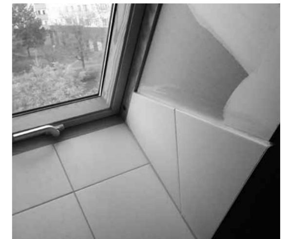
■ Neue Fenster nach energetischem Standard
