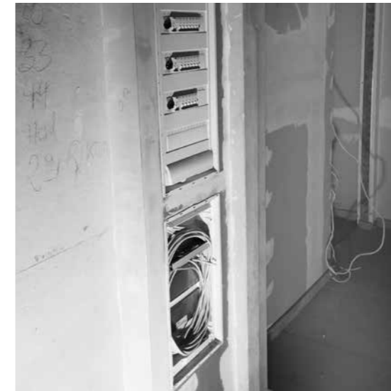
■ Erneuerung der elektrischen Anlagen
