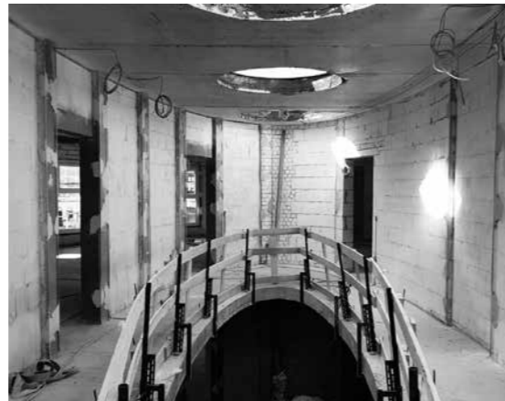
■ Baustelle Kita Bendastraße, Innenansicht
